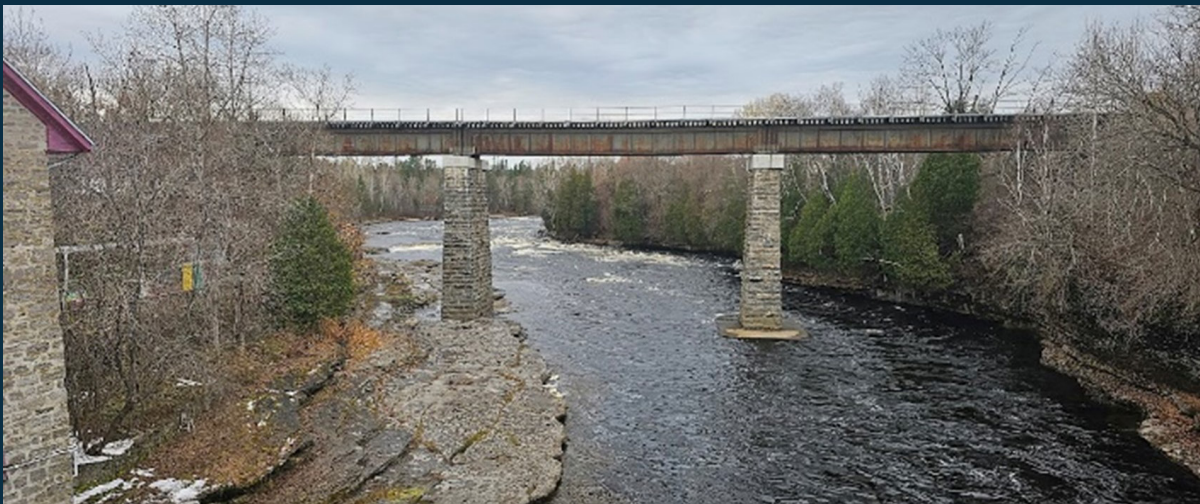
Traversée ferroviaire de la rivière Jacques-Cartier.
