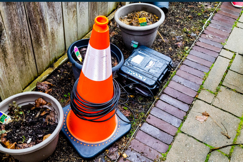
Installation de dispositifs de contrôle des vibrations.
